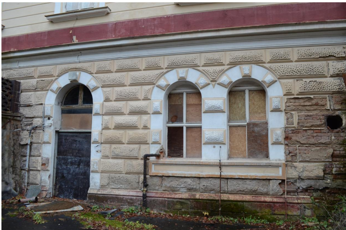
Obr. 3 Jediný úsek nižší úrovně fasády s původním plastickým členěním, výplně oken druhotné, světlík dveří původní
