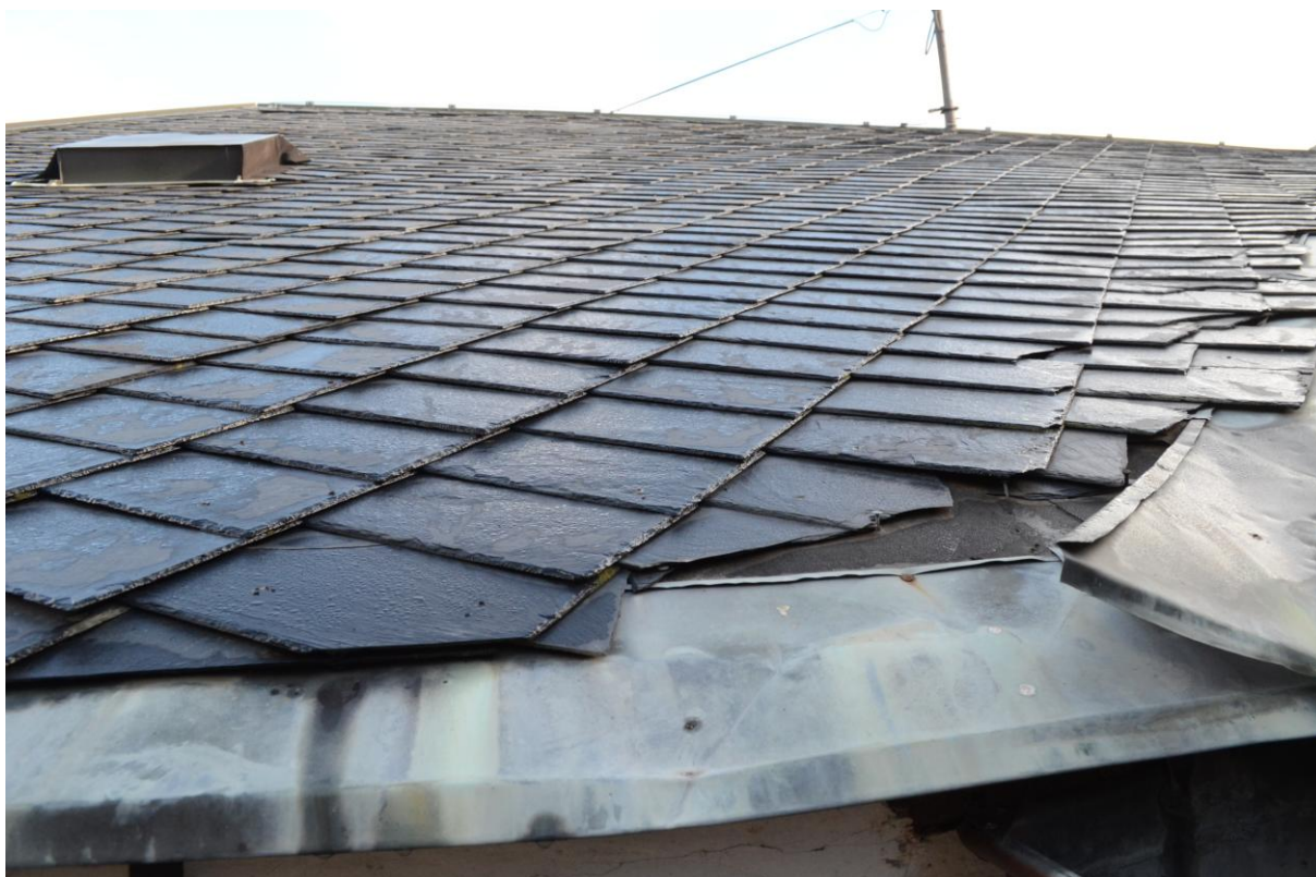
Obr. 6 Detail poškození krytiny střechy (při severozápadní fasádě)
