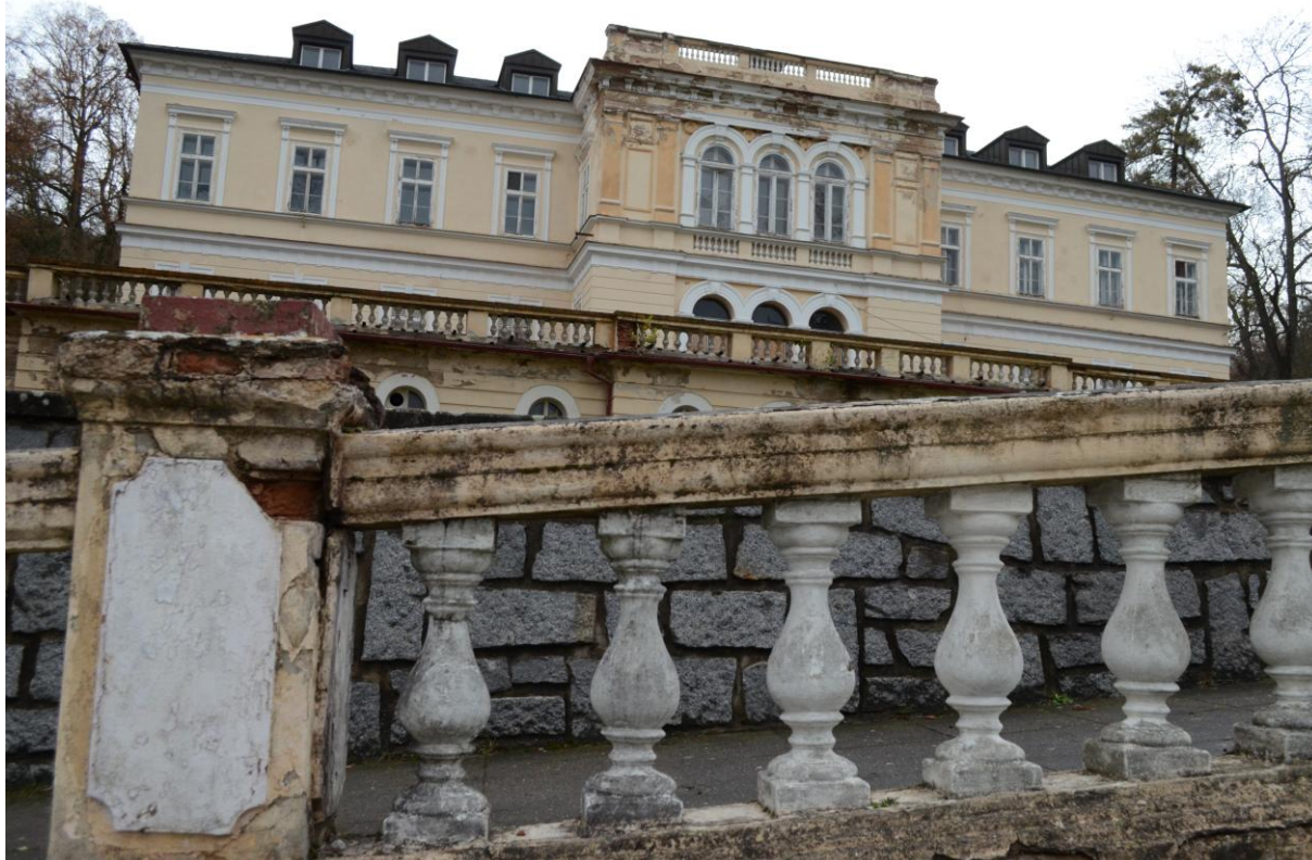
Obr. 2 Balustráda nástupu před terasu má madlo a sloupky v původní podobě na rozdíl od balustrády terasy
